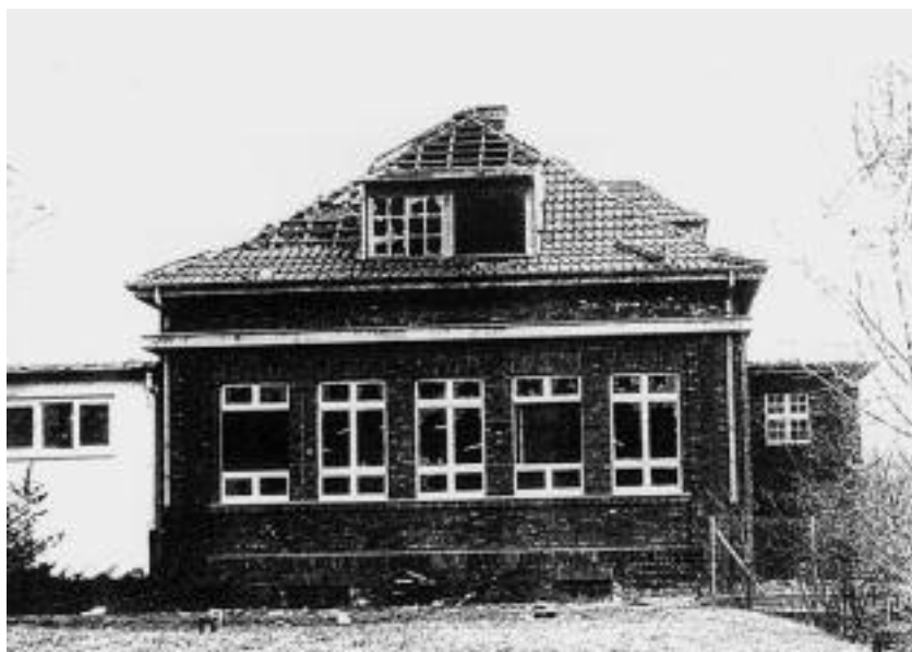
Mädchenberufsschule Mülheimer Straße 37. Gebaut in den 20er-Jahren – heute steht hier das neue Ärztehaus
