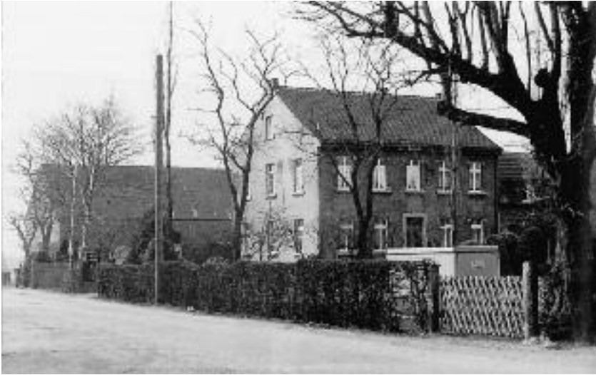
Der Heisterhof am Reimelsweg in Mündelheim vor dem Umbau. Auf diesem Hof lebte die Familie Steingen im 18. und 19. Jahrhundert
