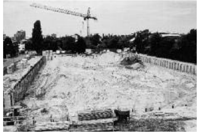
Mit dem Bau des großen Regenrückhaltebeckens verschwanden auf dem Gelände vor der Eissporthalle (im Hintergrund rechts) Park und Kinderspielplatz und auch die letzte Erinnerung an eine vormals mysteriöse Geschichte
