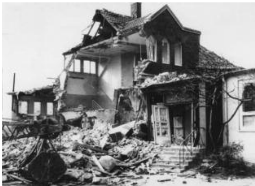
Das völlig zerstörte Gebäude der Mädchenberufsschule Mülheimer Straße 37
