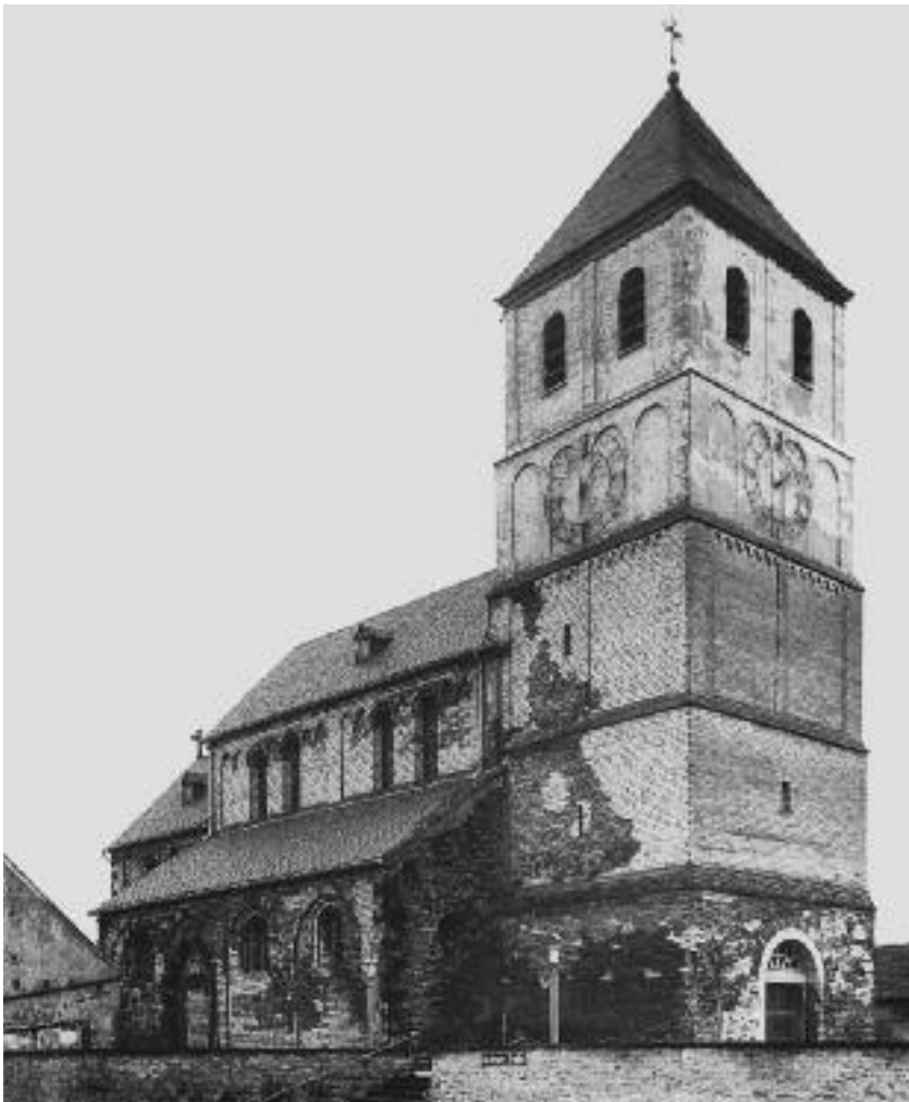
Die romanische Pfarrkirche St. Dionysius in Mündelheim aus dem 13. Jahrhundert. Die Kirche wurde in den letzten Kriegstagen durch Artilleriebeschuss stark zerstört
