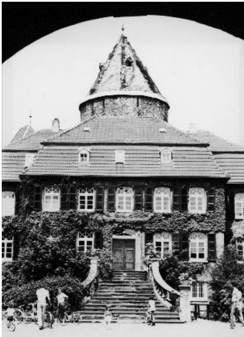
Schloss Linnep mit der großen Aufgangstreppe vor der Restaurierung
