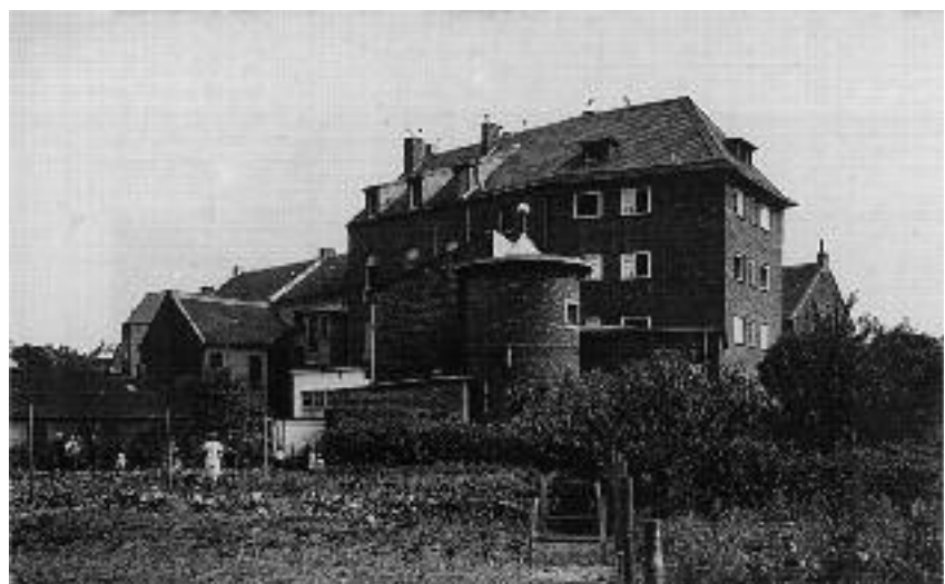
Das Ferdinand-Cremer-Haus an der Angerstraße Ende der 1950er-Jahre, von der Gartenseite her gesehen. Das Haus hieß damals im Volksmund „Bullenkloster“, da es als Wohnheim für alleinstehende Handwerksgesellen diente. Heute befindet sich in ihm das „Anger-Hotel“
