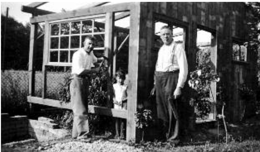
Beim Bau des Schuppens: links Jean Frohnhoff, rechts Wilhelm Jüntgen. In der Mitte Werner Frohnhoff als eifriger Helfer
