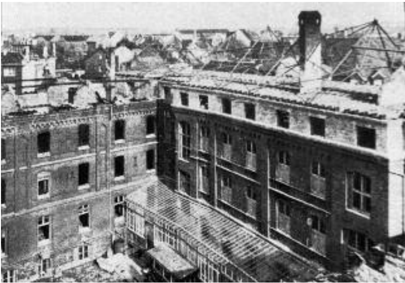
Das zerstörte Marien-Krankenhaus an der Ecke Oberstraße/Angerstraße nach dem Bombenangriff vom 22. März 1945
