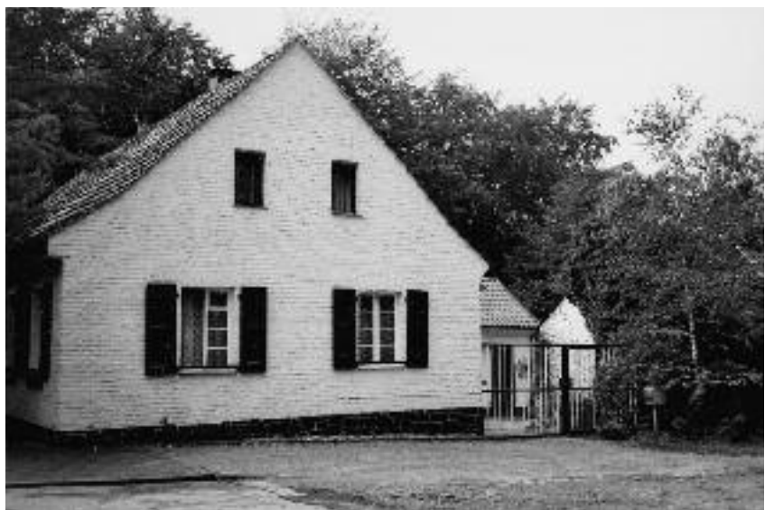
Das Haus „Am trockenen Stiefel“ an der Mülheimer Straße im heutigen Zustand. Ganz rechts hinter den Bäumen der alte Stall
